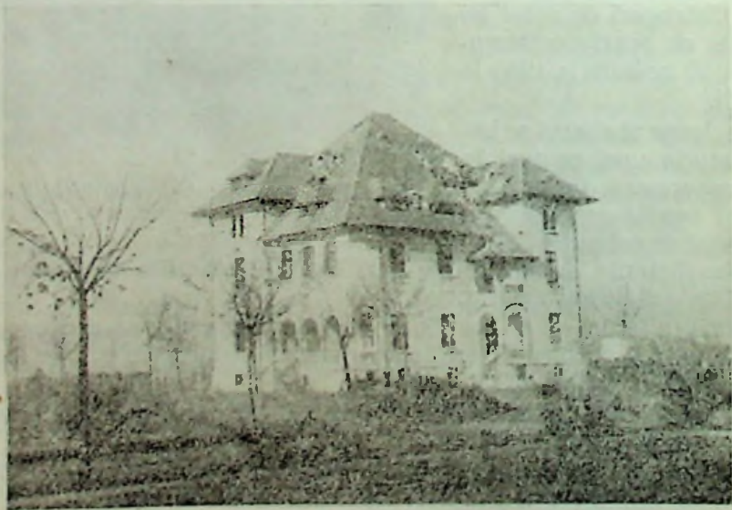
Fig. 129. Căderea lîpică a coșurilor cu ocazia cutremurului din 10 noiembrie 1940, de la București.
