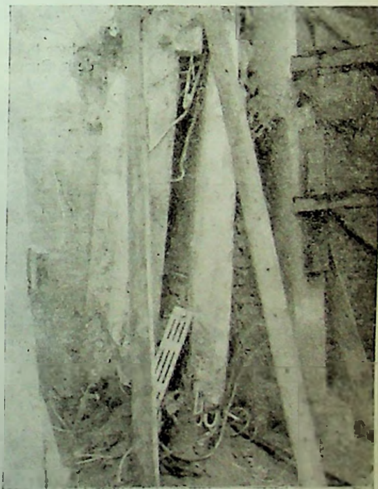
Fig. 111. Stîlpul de la parterul fostei clădiri Carlton găsit în subsolul II, forfecat la bază.
