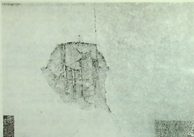
Fig. 113. Stîlp cu armături flambate la cutremurul din 10 noiembrie 1940, de la București.
