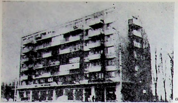
Fig. VI.36. — Blocul de locuințe „Dioda” din București, bd. 1 Mai. Clădire nouă cu diafragme de beton armat monolit și parter flexibil (parter și 6 etaje); a — Vedere de ansamblu; b — Avarii la caja liftului; c — Stîlp avariat la capătul superior (parter).
