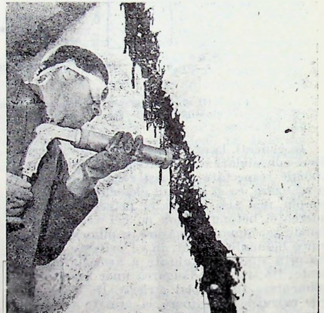
Fig. VIII.7. — Injectarea fisurilor din elementele de beton armat, cu rășini epoxidice : a — Executarea orificiilor de injectare pe traseul fisurilor ; b — Fixarea stuțurilor de PVC în orificiile executate ; c — Astuparea fisurii cu chit epoxidic ; d — Efectuarea injectării rășinii epoxidice cu un pistol cu aer comprimat, introdus în stuț.
