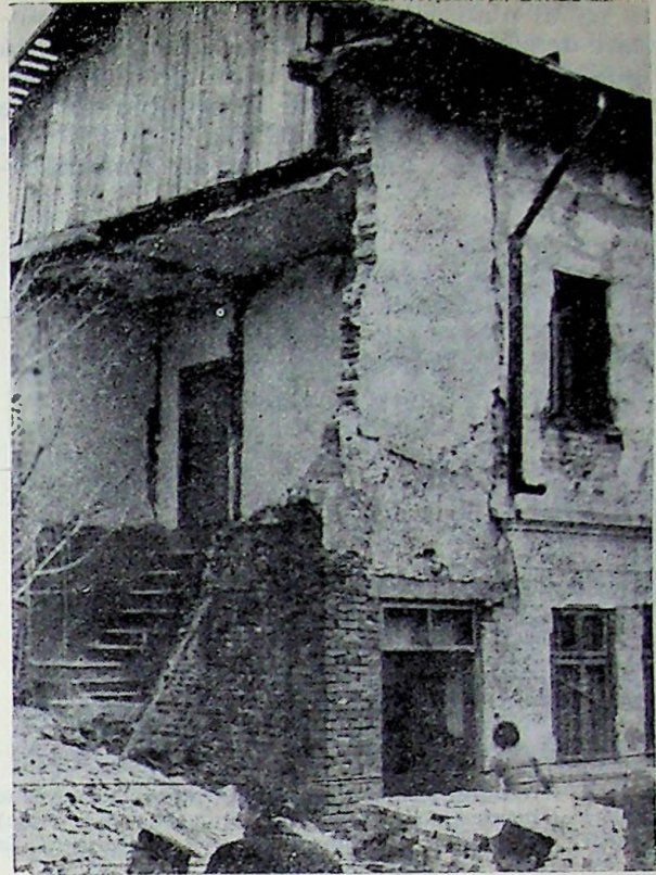
Fig. VI.3. — Clădire din Filipești de țirg (județul Prahova) prăbușită parțial la cutremur.
