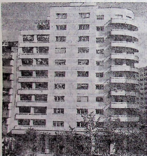
Fig. VI.8. — Blocul de locuințe „Casata” din București, bd. Magheru 26 : a — Vedere înainte de cutremur (clădire veche cu schelet de beton armat, parter și 6...10 etaje). b — Vedere după cutremur (prăbușire aproape totală: partea rămasă a fost demolată ulterior); c — Blocul nou construit pe același amplasament (clădire cu cadre de beton armat, parter și 8...10 etaje).
