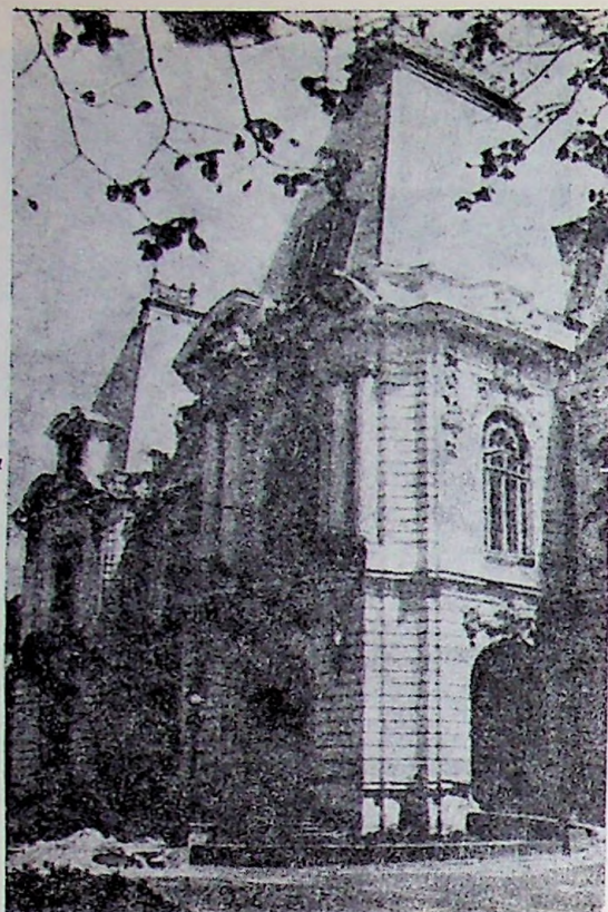
Fig. VI.70. — Palatul culturii din Ploiești. Clădire veche din zidărie portantă. Prăbușirea unei porțiuni din zidăria fațadei.
