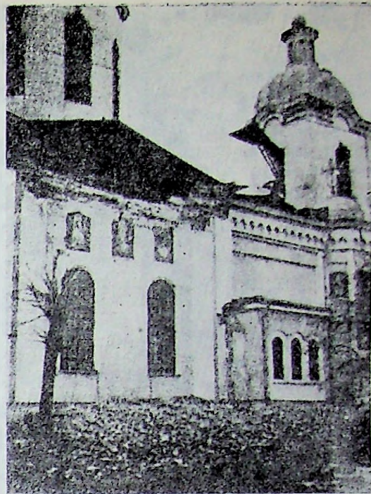
Fig. VI.67. — Biserici avariate de cutremur. Prăbușiri de turle și avarii la zidărie : a — Biserica Sf. Spiridon din București ; b — Biserica Sf. Vasile din Ploiești.
