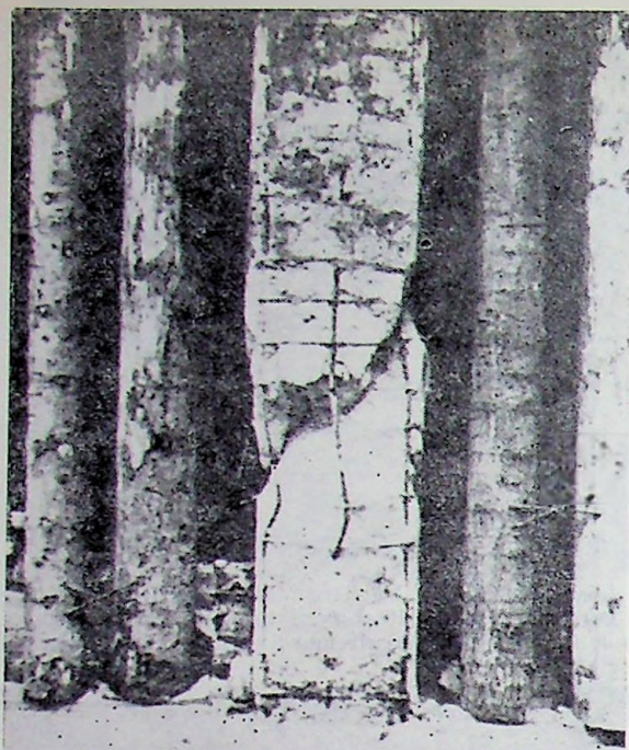
Fig. VI.18. — Stâlpi de beton armat avariați de cutremur la clădiri vechi de locuit din București (rupere la forță tăietoare): a — Stâlp de la parter rupt la blocul de locuințe „Podgoria”; b — Stâlp de la parter rupt la blocul de locuințe din str. Matei Voevod (Austrului), care a fost demolat ulterior din cauza avariilor foarte grave suferite la cutremur.
