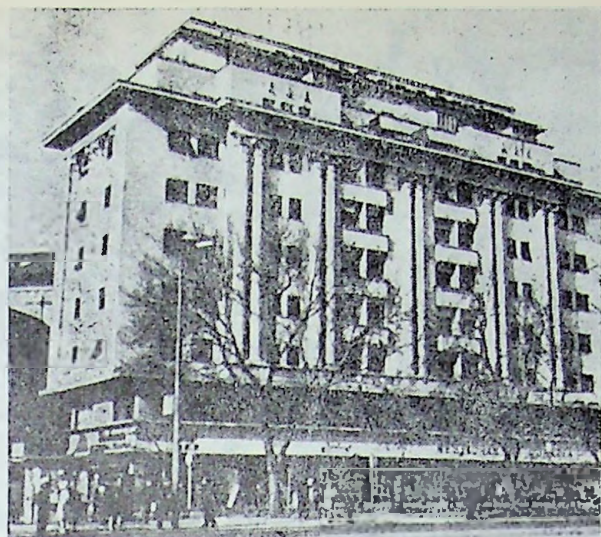
Fig. VI.11. — Blocul de locuințe „Dunărea” din București, bd. Băleescu 3—5: a — Vedere înainte de cutremur (clădire veche cu schelet de beton armat, parter și 8 etaje); b — Vedere după cutremur (prăbușire aproape totală); c — Blocul nou construit prin extinderea amplasamentului (clădire cu cadre de beton armat, parter și 8...11 etaje).
