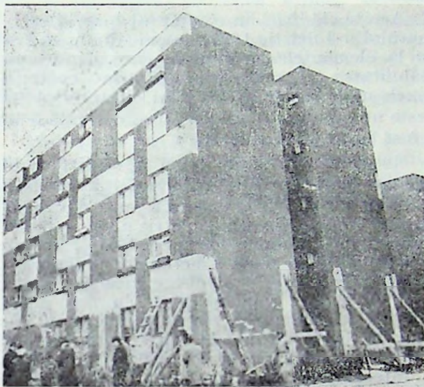
Fig. VI.27. — Clădiri de locuit noi la Craiova, Cartier Valea Roșie din zidărie portantă (parter și 4 etaje): a, b. Avarii la pereții exteriori.
