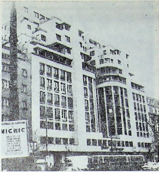
Fig. VI.60. — Hotelul „Ambasador” din București, Bd. Magheru 10. Clădire veche cu schelet de beton armat (parter și 10...12 etaje): a — Vedere de ansamblu înainte de cutremur; b — Avarii la fațadă; c — Avarii la un stâlp de la etajul I; d — Avarii la casa scării.
