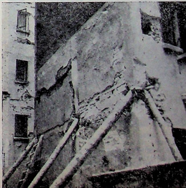
Fig. VI.17. — Blocul de locuințe „Pherekyde” din București bd. Bălcescu 24. Clădire veche cu schelet de beton armat (parter și 8...10 etaje); a — Vedere de ansamblu; b — Avarii la fațade și la un stîlp de colț.
