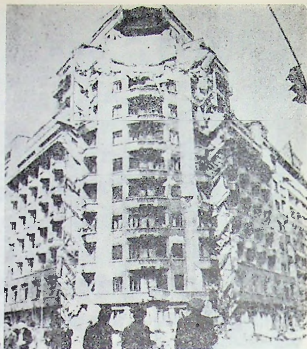
Fig. VI.10. — Blocul de locuințe „Wilson” din București, bd. Bălecescu 25: a — Vedere înainte de cutremur (clădire veche cu schelet de beton armat, parter și 9...11 etaje); b — Vedere după cutremur. Prăbușire pe verticală cu un nivel a colțului clădirii ca urmare a ruperii stîlpilor de la parter (se văd balcoanele laterale înclinate, care reazemă cu un capăt pe părțile clădirii rămase în situația inițială, iar cu celălalt pe porțiunea de colț, scufundată pe verticală cu un nivel); c — Blocul cu colțul reconstruit (modificat prin retragere, față de conturul vechi).
