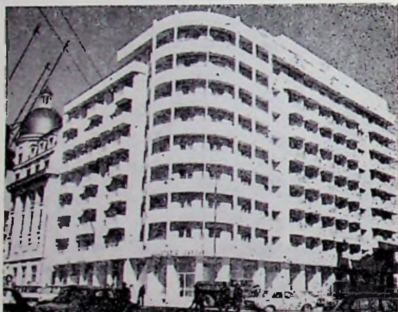
Fig. VI.12. — Blocul de locuințe „Continental” din București, str. Colonadelor (colț cu Str. Ion Ghica): a — Vedere înainte de cutremur (clădire veche cu schelet de beton armat, parter și 10...12 etaje); b — Vedere după cutremur (prăbușire totală); c — Blocul nou construit pe același amplasament (clădire cu cadre de beton armat, parter și 8...10 etaje).
