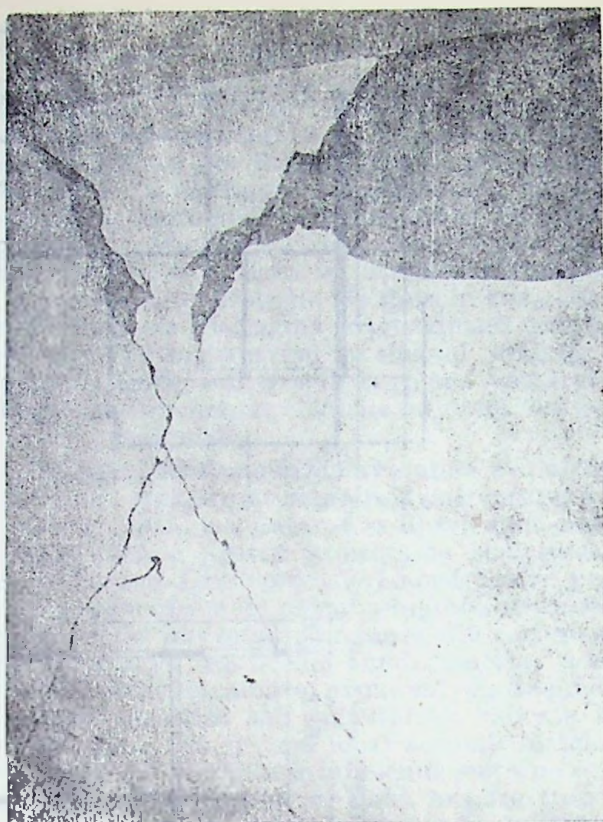
Fig. VI.30. — Clădiri de locuit noi cu structura în diafragme de beton armat monolit : avarii și distrugereri la buiandrugi.
