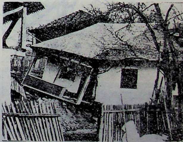
Fig. V.11. — Casă avariată de alunecarea de teren din comuna Slon, județul Prahova (foto: N. Mindrescu).
