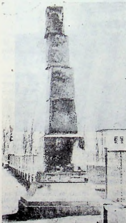
Fig. VI.67. — Biserici avariate de cutremur. Prăbușiri de turle și avarii la zidărie : a — Biserica Sf. Spiridon din București ; b — Biserica Sf. Vasile din Ploiești.
