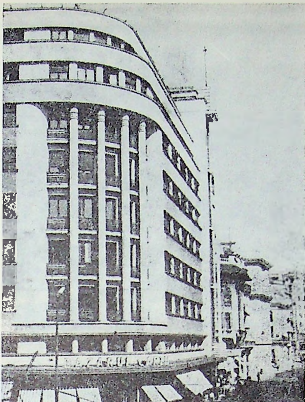
Fig. VI.58. — Blocul „Carpați” (birourile Ministerului Industrii Metalurgice — MIM) din București, str. Academiei nr. 5: a — Vedere înainte de cutremur (clădire veche cu schelet de beton armat, parter și 9 etaje); b — Vedere după cutremur (prăbușire parțială la colțul clădirii); c — Blocul cu colțul reconstruit și consolidat în părțile neprăbușite.
