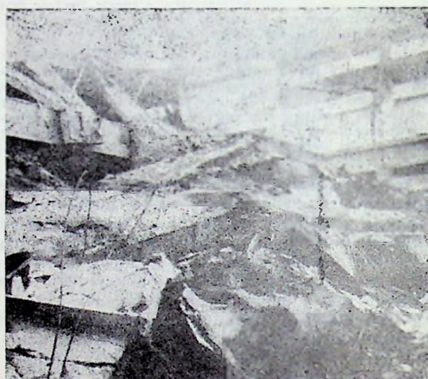
Fig. VI.88. — Centrala termoelectrică CET-Vest, Militari-București. Hală parter pentru sala mașinilor ( l = 42 m) cu structură de beton armat, acoperiș din ferme metalice și elemente secundare din beton armat prefabricat: a — Plan; b — Secție transversală; c — Prăbușirea acoperișului la cutremur.
