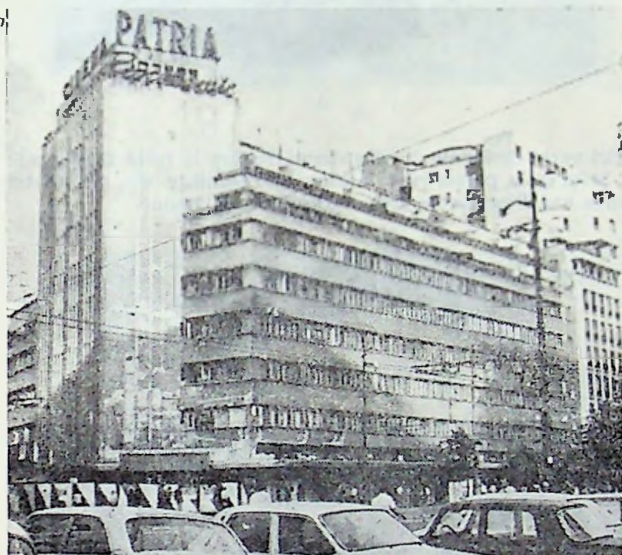
Fig. VI.16. — Blocul de locuințe „Patria” din București, bd. Magheru 12-14. Clădire veche cu schelet de beton armat (parter și 8...12 etaje); a — vedere de ansamblu; b — Stîlp distrus prin forfecare la etajul I.
