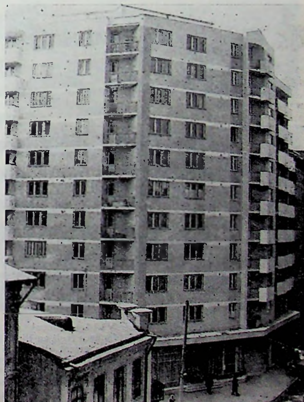
Fig. VI.13. — Blocul de locuințe „Belvedere” din București, str. Brezoianu 7: a — Vedere înainte de cutremur (clădire veche cu schelet de beton armat, parter și 6...13 etaje); b — Partiuł unui etaj curent (se observă forma neregulată în plan și amplasarea neordonată a stîlpilor); c — Vedere după cutremur (prăbușire totală); d — Vedere după cutremur (prăbușire totală); d — Blocul nou construit pe același amplasament (clădire cu cadre de beton armat, parter și 10 etaje).
