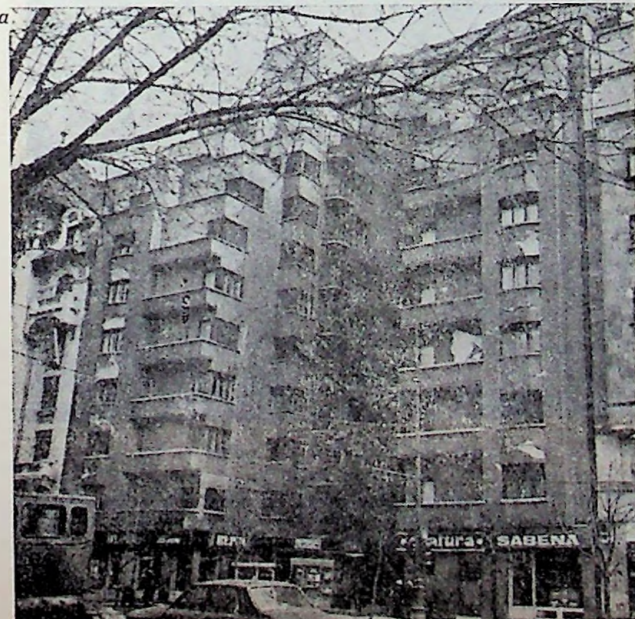
Fig. VI.17. — Blocul de locuințe „Pherekyde” din București bd. Bălcescu 24. Clădire veche cu schelet de beton armat (parter și 8...10 etaje); a — Vedere de ansamblu; b — Avarii la fațade și la un stîlp de colț.
