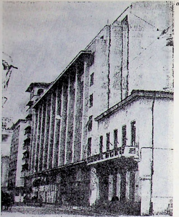
Fig. VI.59. — Blocul de birouri „Cofetăria Republica” (fost Nestor) din București, Calea Victoriei nr. 63—69 : a — Vedere înainte de cutremur (clădire veche cu schelet de beton armat, parter și 8 etaje); b — Vedere după cutremur (prăbușire totală a corpului din față); c — Clădirea reconstruită prin extinderea amplasamentului inițial.
