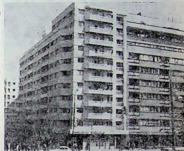
Fig. VI.9. — Blocul de locușe „Cofetăria Scala” din București bd. Bălcescu 35 (colț cu Str. C. A. Rosetti) : a — Vedere înainte de cutremur (clădire veche cu schelet de beton armat, parter și 7...11 etaje) ; b — Vedere după cutremur (prăbușire totală) ; c — Blocul nou, construit pe același amplasament (clădire cu cadre de beton armat, parter și 10 etaje).
