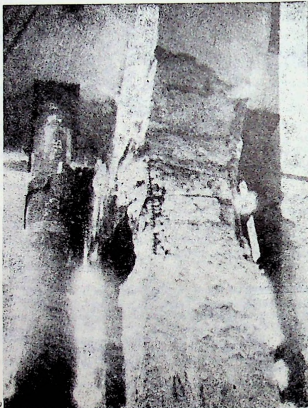
Fig. VI.80. — Tăbăcăria Bucovăț (jud. Dolj). Hală parter în beton armat monolit și zidărie exterioară portantă: a — Vederea părții de clădire prăbușită; b — Avarierea unui stâlp interior de beton armat în zona neprăbușită (rupere la 45°, cu beton expulzat și armătură flambată).
