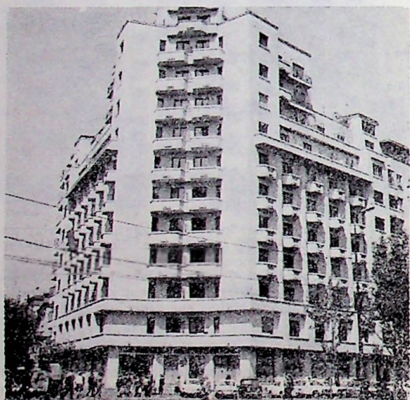
Fig. VI.10. — Blocul de locuințe „Wilson” din București, bd. Bălecescu 25: a — Vedere înainte de cutremur (clădire veche cu schelet de beton armat, parter și 9...11 etaje); b — Vedere după cutremur. Prăbușire pe verticală cu un nivel a colțului clădirii ca urmare a ruperii stîlpilor de la parter (se văd balcoanele laterale înclinate, care reazemă cu un capăt pe părțile clădirii rămase în situația inițială, iar cu celălalt pe porțiunea de colț, scufundată pe verticală cu un nivel); c — Blocul cu colțul reconstruit (modificat prin retragere, față de conturul vechi).
