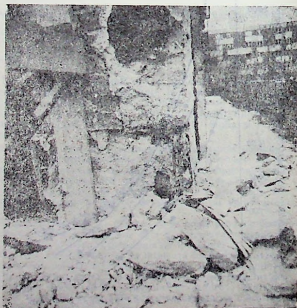
Fig. VII.60. — Detalii de avarii de diafragma provocate de o conformare necorespunzătoare a structurii: a — diafragma de la casa scării fisurată la partea superioară unde s-a desprins de planșeu; b — stâlpișor de beton armat de la intersecția a două diafragma exterioare; se vede armătura dezvelită, ancorată necorespunzător de mustățile din fundație, betonul fisurat.
