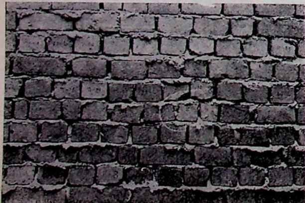
Fig. VII.51. — Exemple de defecțe grave de execuție la o clădire cu cinci niveluri în zonă seismică de grad 8 : a — abateri de la verticală ; b, c — rosturi verticale și orizontale neumplute cu mortar, rosturi verticale neșesute, procente exagerate de fracțiuni de cărămizi, rapoarte de țesere inadmisibile.
