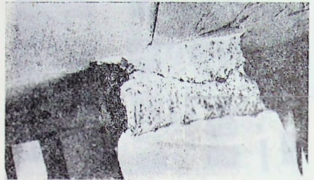
Fig. VI. 65. — Universitatea din București. Cupola Aulei Rectoratului. Clădire veche, cu structură de beton armat: a — Vedere generală din interiorul aulei; b — Avarii la stâlpii interiori, înclinați.
