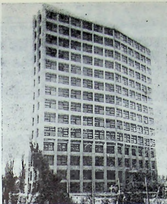
Fig. VI.76. — Clădirea Institutului de geologie și geofizică din București, str. Caransebeș 1. Clădire nouă cu structura în cadre de beton armat monolit (parter și 13 etaje): a — Vedere de ansamblu; b — Secțiune transversală; c — Plan etaj curent.
