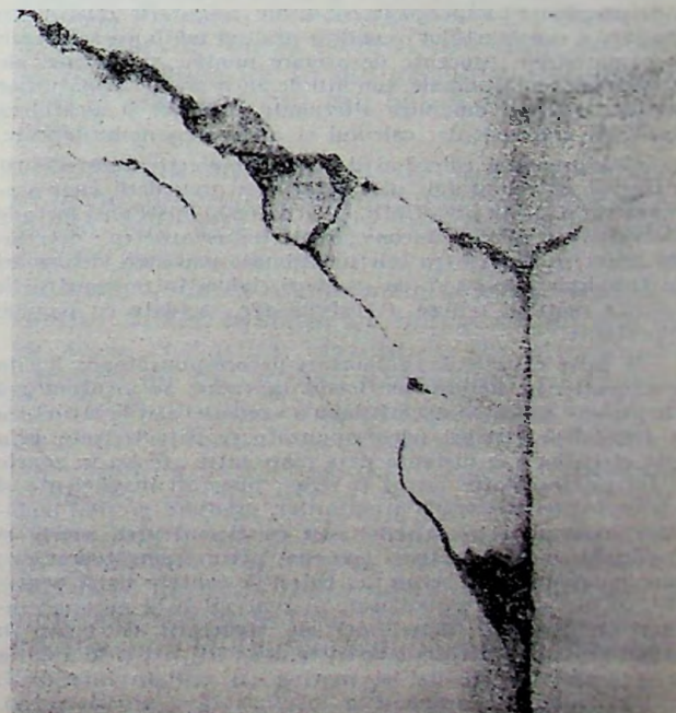
Fig. VI.17. — Avarii la elementele nestructurale de la clădirile noi de locuit din București: a — Avarii la fațade cu pereți din zidărie de blocuri mici de beton celular autoclavizat (Blocul de locuințe nr. 18 din șos. Pantelimon); b — Avarii la pereți interiori (Blocul de locuințe nr. 9 din Calea Dorobanți).
