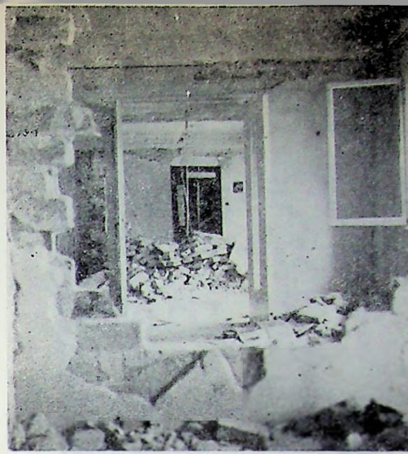
Fig. VI.15. — Blocul de locuințe „Podgoria” din București, str. N. Beldian (colț cu Bd. Magheru). Clădire veche cu schelet de beton armat (parter și 8...10 etaje), consolidată parțial după cutremurul din 1940 și avariată grav la cutremurul din 4 martie 1977, mai ales la partea neconsolidată; a — Vedere de ansamblu, după cutremur; b — Vedere interioară a pereților prăbușiți la etajul I.
