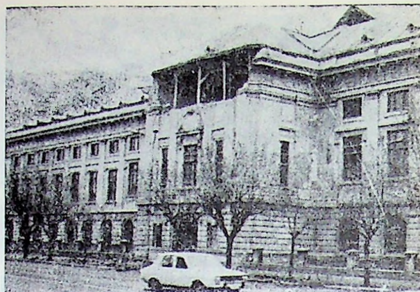
Fig. VI.70. — Palatul culturii din Ploiești. Clădire veche din zidărie portantă. Prăbușirea unei porțiuni din zidăria fațadei.
