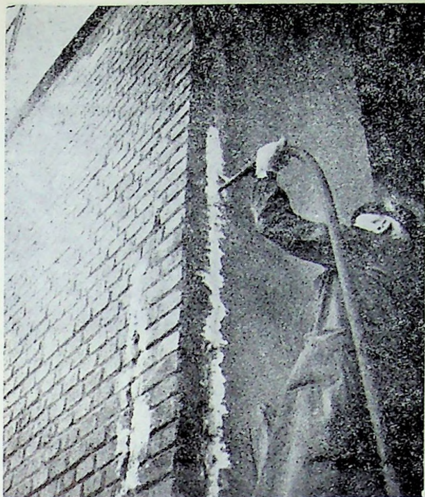
Fig. VIII.20. — Injectarea cu pastă de ciment a zidărilor avariate de cutremur: Aspecte de la operațiile de injectare a pastei de ciment, cu ajutorul unui pistol cu aer comprimat.
