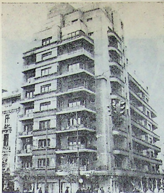
Fig. VI.15. — Blocul de locuințe „Podgoria” din București, str. N. Beldian (colț cu Bd. Magheru). Clădire veche cu schelet de beton armat (parter și 8...10 etaje), consolidată parțial după cutremurul din 1940 și avariată grav la cutremurul din 4 martie 1977, mai ales la partea neconsolidată; a — Vedere de ansamblu, după cutremur; b — Vedere interioară a pereților prăbușiți la etajul I.
