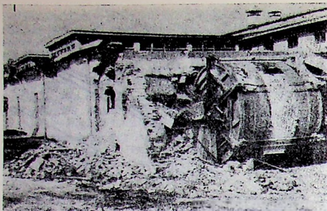
Fig. VI.80. — Tăbăcăria Bucovăț (jud. Dolj). Hală parter în beton armat monolit și zidărie exterioară portantă: a — Vederea părții de clădire prăbușită; b — Avarierea unui stâlp interior de beton armat în zona neprăbușită (rupere la 45°, cu beton expulzat și armătură flambată).
