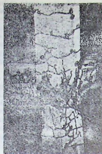
Fig. VII.15. a — Articulație plastică pe stlfp; b — Rupere de stlfp.
