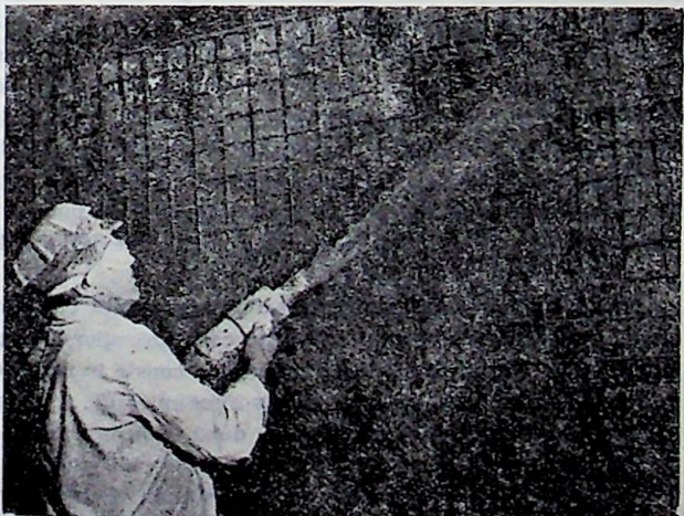
Fig. VIII.14. — Cămășuirea prin torcretare a diaframelor de beton armat avariate de cutremur: a — Diafragmă pregătită pentru torcretare, cu armătura montată; b — Efectuarea torcretării.
