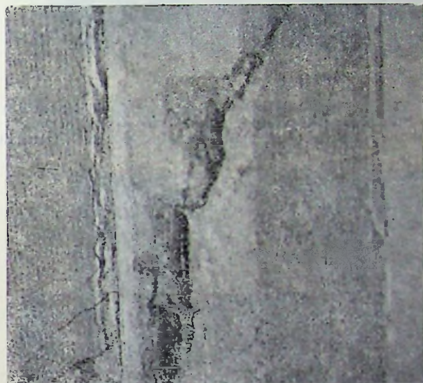
Fig. VI.16. — Blocul de locuințe „Patria” din București, bd. Magheru 12-14. Clădire veche cu schelet de beton armat (parter și 8...12 etaje); a — vedere de ansamblu; b — Stîlp distrus prin forfecare la etajul I.
