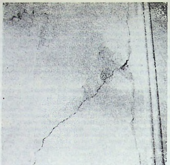
Fig. VI.45. — Stâlpi de beton armat avariați de cutremur la structuri în cadre, de la clădiri de locuit noi cu multe niveluri, din București: a — Stâlp de colț la parter, avariat la capătul inferior (Blocul de locuințe 118 — 128 din șos. Ștefan cel Mare); b — Stâlp de la parter, cu rupere înclinată (Blocul de locuințe nr. 10 din Calea Dorobanți).
