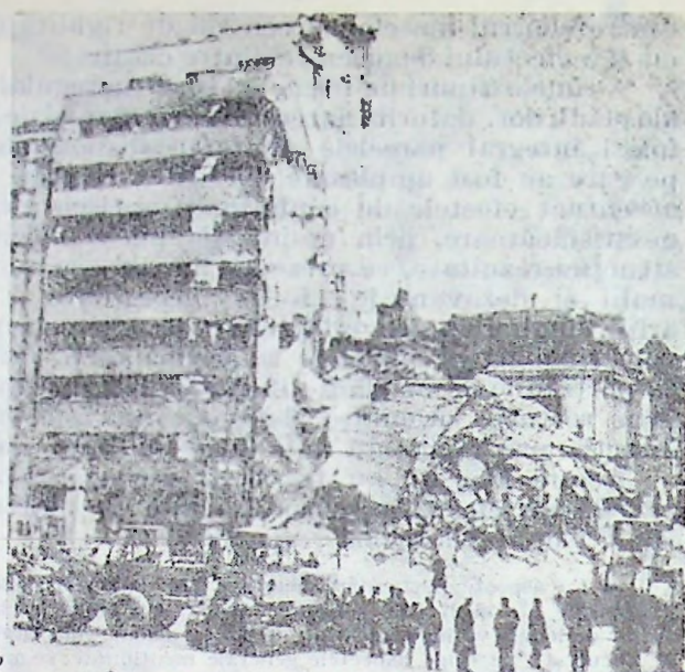
Fig. VI.8. — Blocul de locuințe „Casata” din București, bd. Magheru 26 : a — Vedere înainte de cutremur (clădire veche cu schelet de beton armat, parter și 6...10 etaje). b — Vedere după cutremur (prăbușire aproape totală: partea rămasă a fost demolată ulterior); c — Blocul nou construit pe același amplasament (clădire cu cadre de beton armat, parter și 8...10 etaje).
