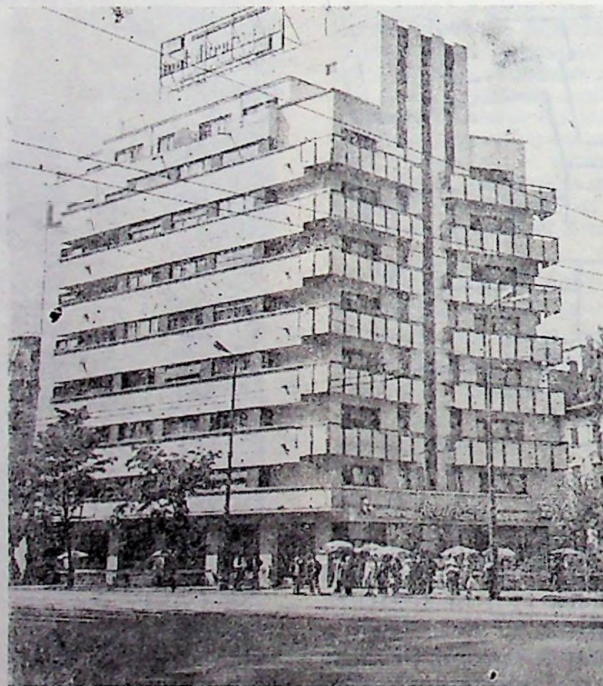
Fig. VI.14. — Blocul de locuințe „Turist” din București, bd. Magheru (colț cu Piața Romană). Clădire veche cu schelet de beton armat (parter și 9 etaje): a — Vedere după cutremur (avarierea gravă a parterului a necesitat o sprijinire generală); b — Stîlp rupt la parterul clădirii; c — Vederea clădirii după consolidare (se observă retragerea prin tăierea colțului clădirii).
