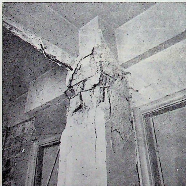
Fig. VI.19. — Stâlpi de beton armat avariați de cutremur la clădiri vechi de locuit din București (rupere prin compresiune din încovoiere): a — Stâlp de la parter rupt la capătul inferior (blocul de locuințe din Str. Matei Voevod); b — Stâlp de la etajul II rupt la capătul superior (blocul de locuințe din str. Apolodor 31, cu prăbușire parțială).
