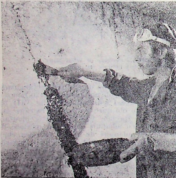
Fig. VIII.7. — Injectarea fisurilor din elementele de beton armat, cu rășini epoxidice : a — Executarea orificiilor de injectare pe traseul fisurilor ; b — Fixarea stuțurilor de PVC în orificiile executate ; c — Astuparea fisurii cu chit epoxidic ; d — Efectuarea injectării rășinii epoxidice cu un pistol cu aer comprimat, introdus în stuț.
