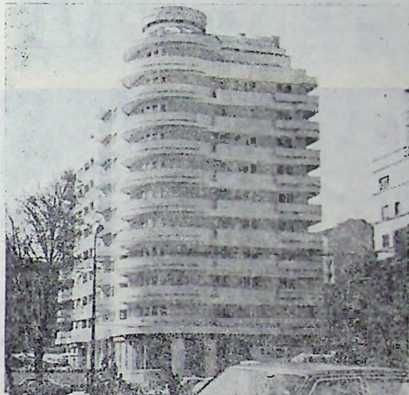
Fig. VI.11. — Blocul de locuințe „Dunărea” din București, bd. Băleescu 3—5: a — Vedere înainte de cutremur (clădire veche cu schelet de beton armat, parter și 8 etaje); b — Vedere după cutremur (prăbușire aproape totală); c — Blocul nou construit prin extinderea amplasamentului (clădire cu cadre de beton armat, parter și 8...11 etaje).
