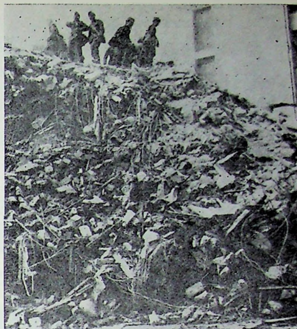
Fig. VI.13. — Blocul de locuințe „Belvedere” din București, str. Brezoianu 7: a — Vedere înainte de cutremur (clădire veche cu schelet de beton armat, parter și 6...13 etaje); b — Partiuł unui etaj curent (se observă forma neregulată în plan și amplasarea neordonată a stîlpilor); c — Vedere după cutremur (prăbușire totală); d — Vedere după cutremur (prăbușire totală); d — Blocul nou construit pe același amplasament (clădire cu cadre de beton armat, parter și 10 etaje).
